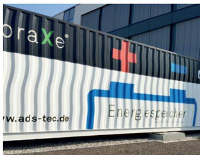
ENERGIESPEICHER: Die Lithium-Ionen-Batterie fungiert als Zwischenspeicher
