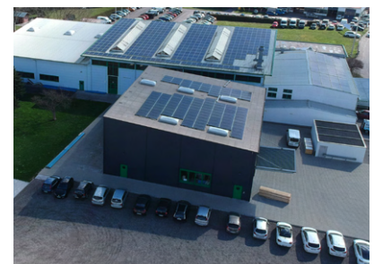
Foto: Lanner Anlagenbau GmbH
